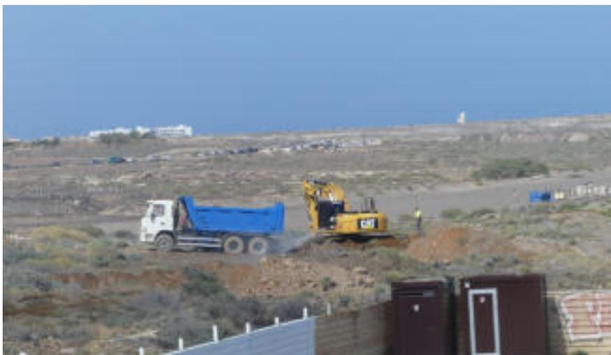
La imagen se corresponde con una de las operaciones de carga del escombros procedente del desmonte del terreno.
