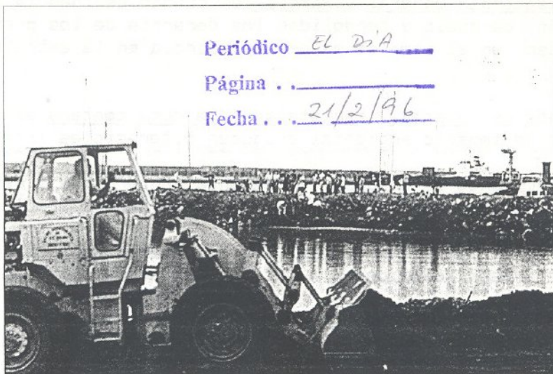
Obra de aterramiento de la playa de El Roque, en Santa Cruz de La Palma
